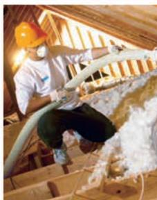
La technique de soufflage garantit une répartition uniforme de la laine à souffler SUPAFIL LOFT sur toute la surface des combles perdus.
