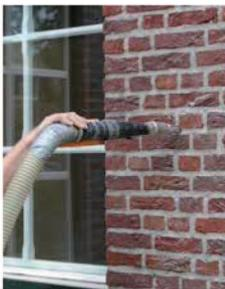
La SUPAFIL CAVITY WALL est insufflée via les orifices dans les murs creux du bas vers le haut.
