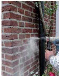
L'installateur SEI agréé choisit l'embout adéquat et fore des trous aux jointures dans le mur suivant un schéma de forage spécifique.
