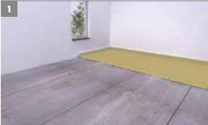
1 Nettoyer le support de tout résidu qui pourrait endommager le panneau et éliminer les irrégularités supérieures à 5 mm. Le support ne peut pas être humide (membrane). Placer d'abord les bandes d'isolation périphérique verticalement contre le mur afin d'éviter la transmission latérale du bruit.
