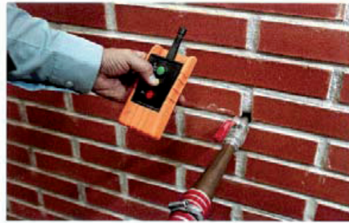
Tras practicar los orificios necesarios para una distribución óptima del material, se procede a la inyección a presión a través de ellos.
