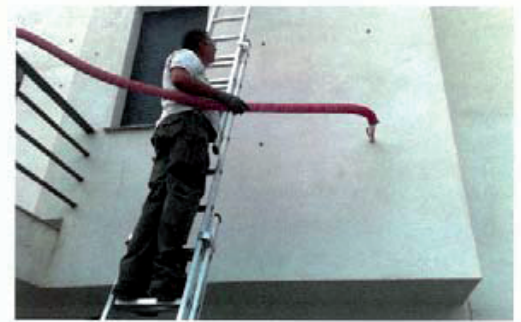
Tras practicar los orificios necesarios para una distribución óptima del material, se procede a la inyección a presión a través de ellos.
