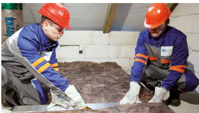
Przycinamy odcinki wełny równe odległości między krokwiemi z 2 cm naddatkiem.
