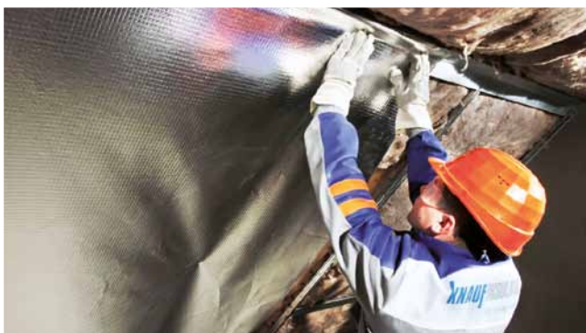
Montujemy na całej powierzchni poddasza folię paroizolacyjną z 10 cm zakładem. Zaleca się stosowanie folii szczególnie w pomieszczeniach wilgotnych (kuchnia, łazienka, WC).
