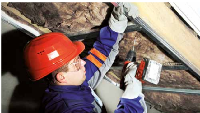
Montujemy poziomy systemowy ruszt metalowy, np. Knauf składający się z wieszaków dystansowych typu U oraz profili nośnych typu CD lub profili sprężystych TN. W zależności od typu wieszaków mocujemy je do czoła krokwi lub boku krokwi w rozstawie zalecanym przez producenta systemu. Można też stosować łąty drewniane.
