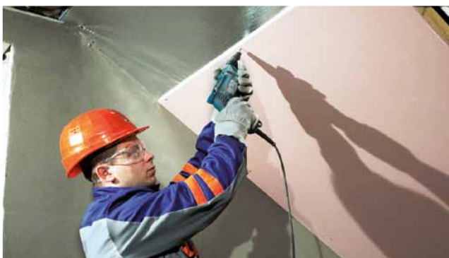
Montujemy warstwę wykończeniową z płyt gipsowo-kartonowych, np. Knauf lub inne płyty wykończeniowe stosowane we wnętrzach.
