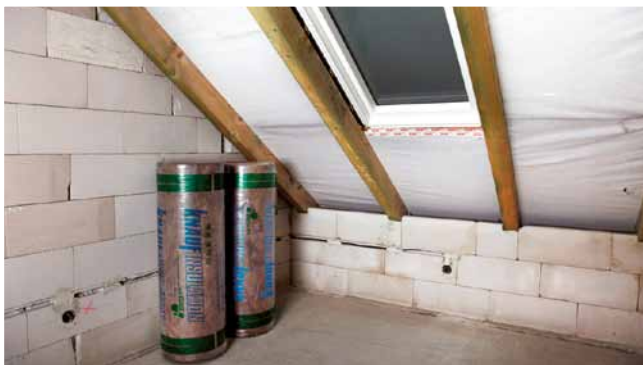
Przygotowanie izolacji. Kontrola krokwi z założoną warstwą wstępnego krycia paroprzepuszczalną.
