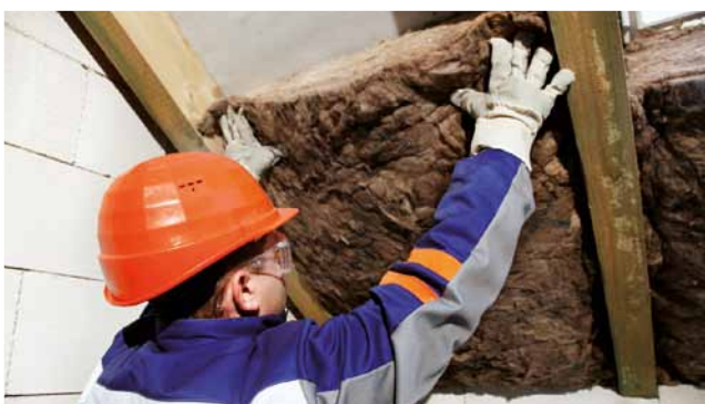
Układamy pierwszą warstwę termoizolacji pomiędzy krokwiemi zwracając uwagę na szczelne przyleganie izolacji do siebie i do elementów konstrukcji poddasza. Wełnę mineralną w razie potrzeby zabezpieczamy sznurkiem lub linką.
