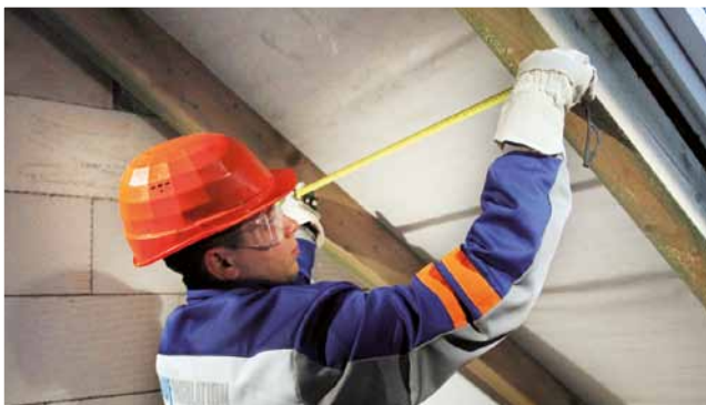
Dokładny pomiar rozstawu krokwi w świetle.
