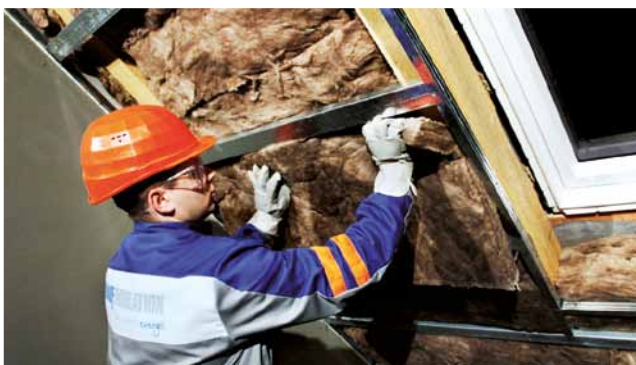
Układamy drugą warstwę termoizolacji pod krokwiemi między listwami rusztu. Druga warstwa izolacji zmniejsza straty ciepła przez drewniane krokwie, co podnosi izolacyjność cieplną całego układu dachu.
