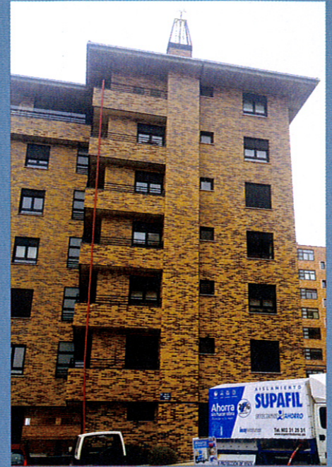
Intervención desde el exterior en vivienda unifamiliar insuflando lana mineral.
