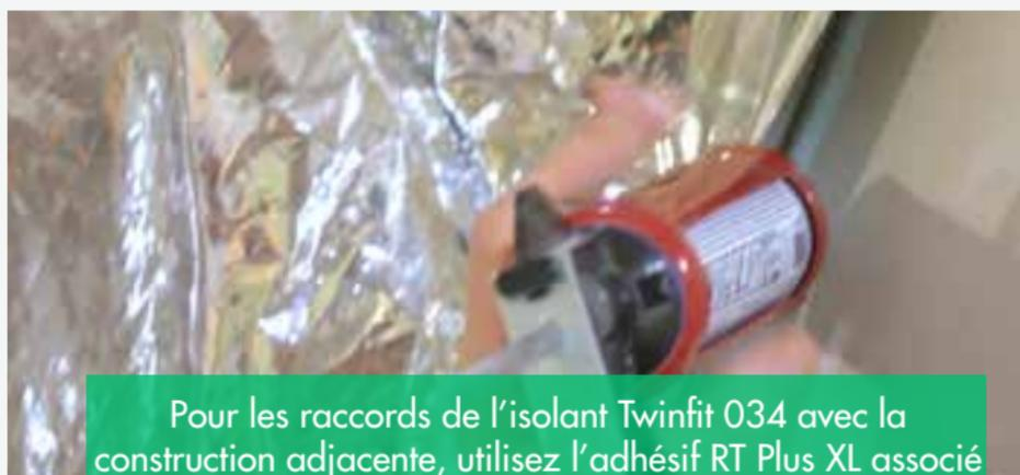
Pour les raccords de l'isolant **Twinfit 034** avec la construction adjacente, utilisez l'adhésif **RT Plus XL** associé au **Homeseal LDS Solimur 310**.
