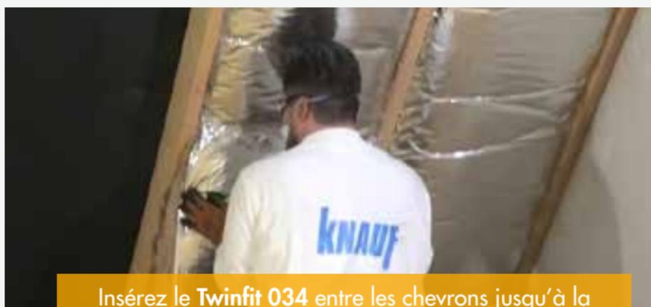
Insérez le **Twinfit 034** entre les chevrons jusqu'à la sous-toiture en faisant affleurer le pare-vapeur.
