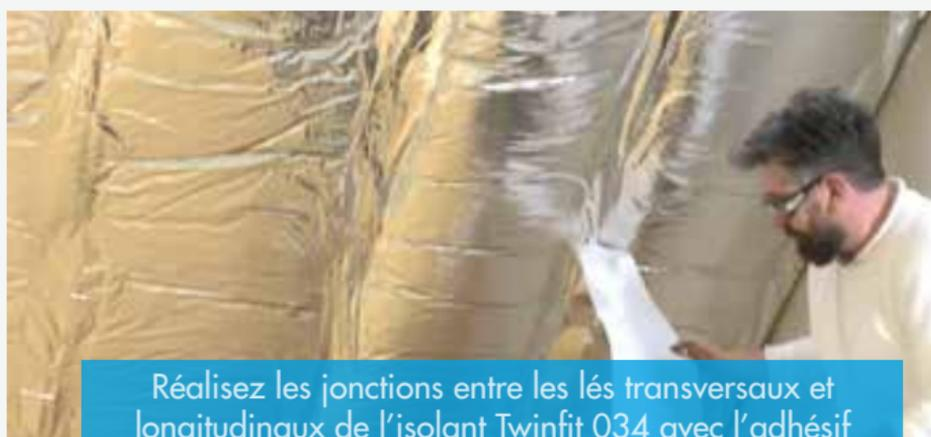
Réalisez les jonctions entre les lés transversaux et longitudinaux de l'isolant **Twinfit 034** avec l'adhésif **RT Plus XL**.
