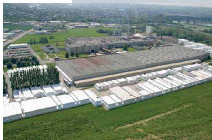
Site de production à Visé
