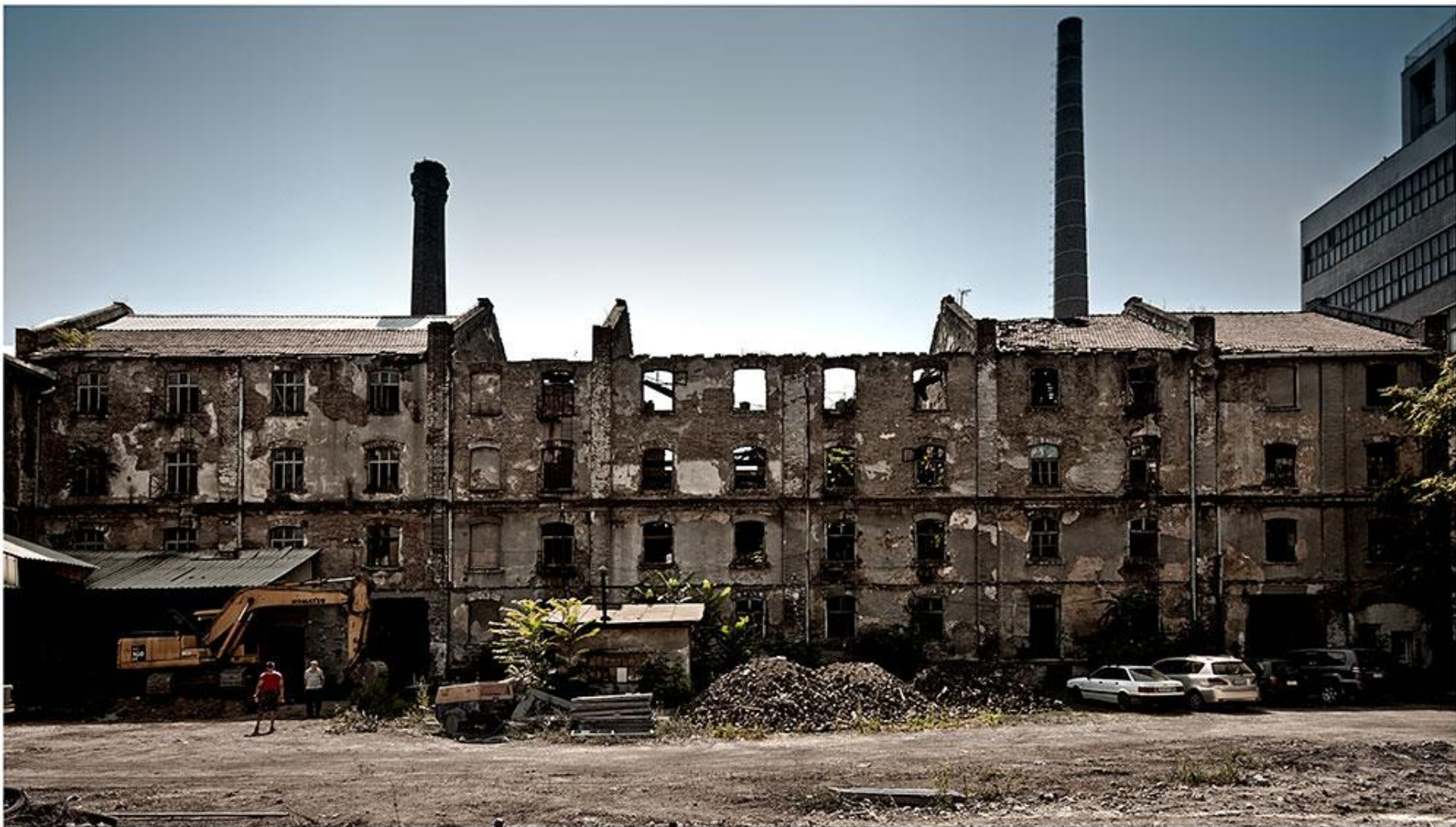
OSTACI ZGRADE POSLE POŽARA NEPOSREDNO PRE POČETKA RADOVA
