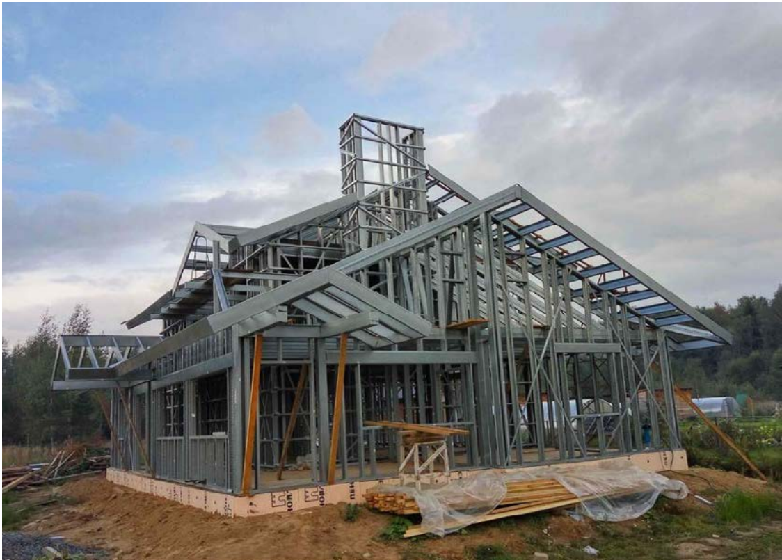
Рисунок 5.1 – Вариант конструктивного исполнения здания с несущим стальным каркасом из тонколистовых оцинкованных холодногнутых профилей
