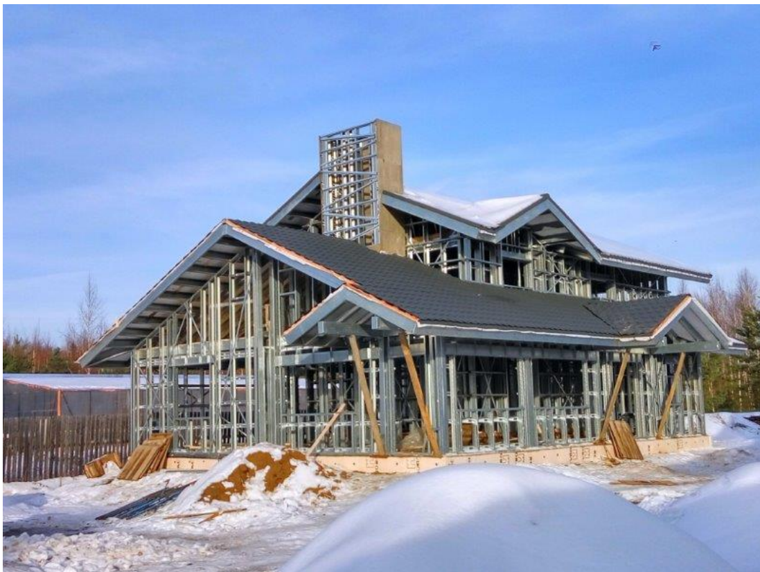
Рисунок 5.2 – Вариант конструктивного исполнения здания с несущим стальным каркасом из тонколистовых оцинкованных холодногнутых профилей
