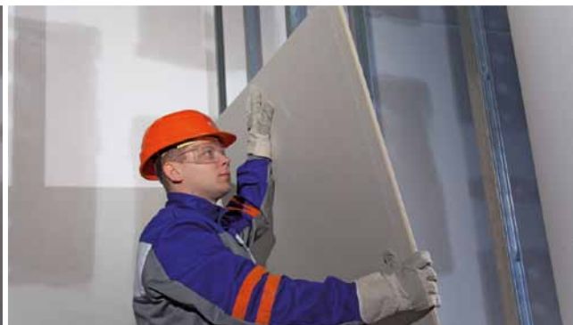
Montaż pierwszej strony ściany, czyli płyt gipsowo-kartonowych do przygotowanego rusztu.
