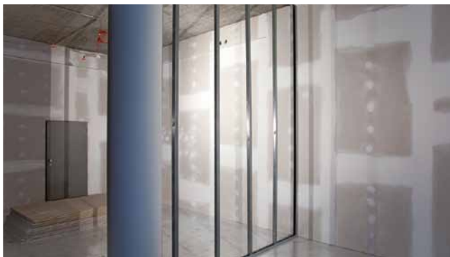
Sprawdzenie poprawności montażu szkieletu.
