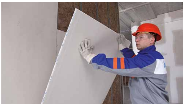
Montaż drugiej warstwy okładziny z płyt g-k do rusztu nośnego, druga warstwa musi pokrywać połączenia warstwy pierwszej płyt g-k.
