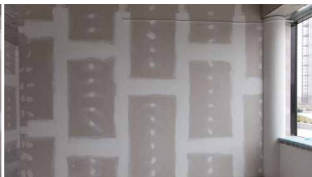
Uszczelnienie połączeń pomiędzy płytami oraz łączy punktowych do szkieletu nośnego.
