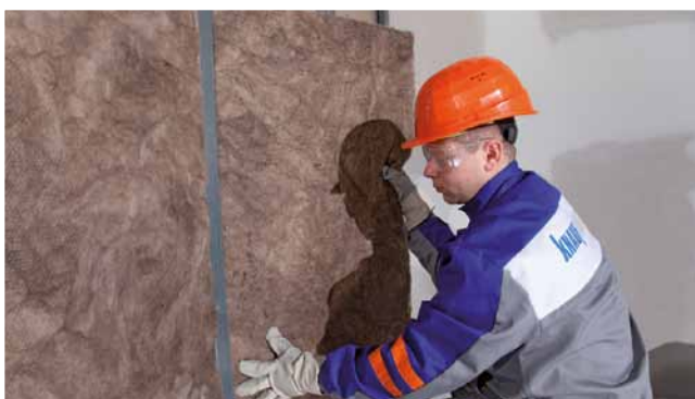
Montaż wełny mineralnej pomiędzy słupki rusztu nośnego, montaż na lekki wcisk.
