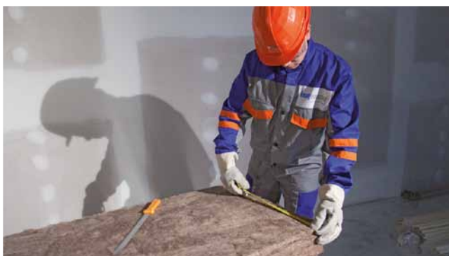
Odmierzenie i przycięcie odpowiedniej ilości wełny mineralnej dla standardowego wypełnienia; standardowy rozstaw słupków pionowych 600mm
