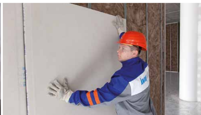
Montaż pierwszej warstwy okładziny z płyt g-k do szkieletu nośnego.
