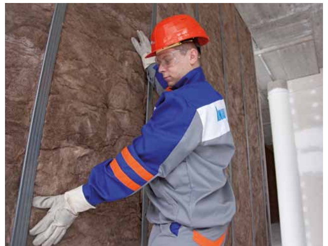
Prosek Point - ścianki działowe w systemach lekkiej zabudowy z TI 140 Decibel W ECOSE® Technology. Ścianki oddzielającej poszczególne obszary biurowe.
