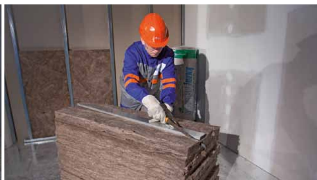
Przycięcie odpowiedniej ilości wełny mineralnej dla niestandardowych przestrzeni.
