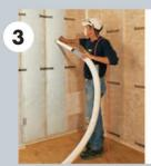
Placez la tête de soufflage dans la cavité et insufflez Le produit SUPAFIL TIMBER FRAME. Remplissez la cavité du bas vers le haut jusqu'à ce que le volume soit complètement rempli à la bonne densité.
